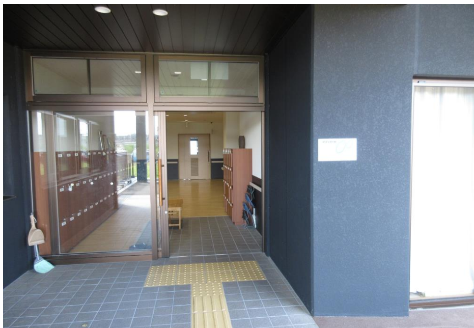
機器を設置している建物入口の写真
